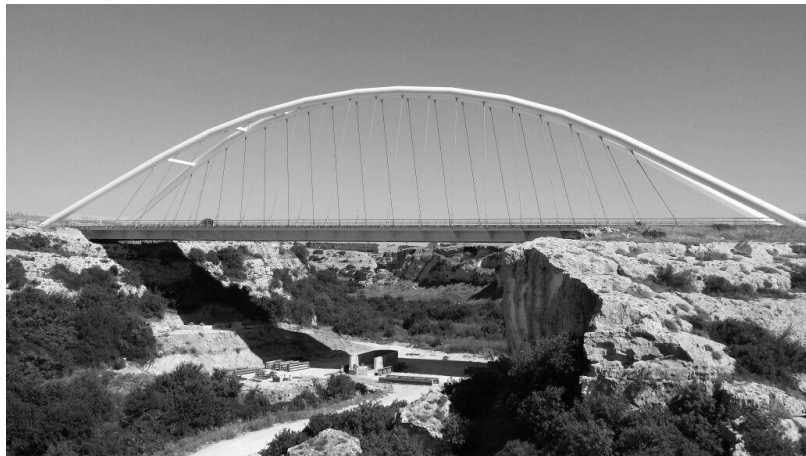
Fig. 2. Il sistema di sospensione e la forma dell'arco
