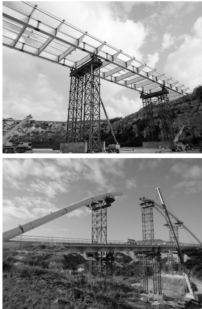
Fig. 7. Il montaggio dell'impalcato (sopra) e dell'arco (sotto)
