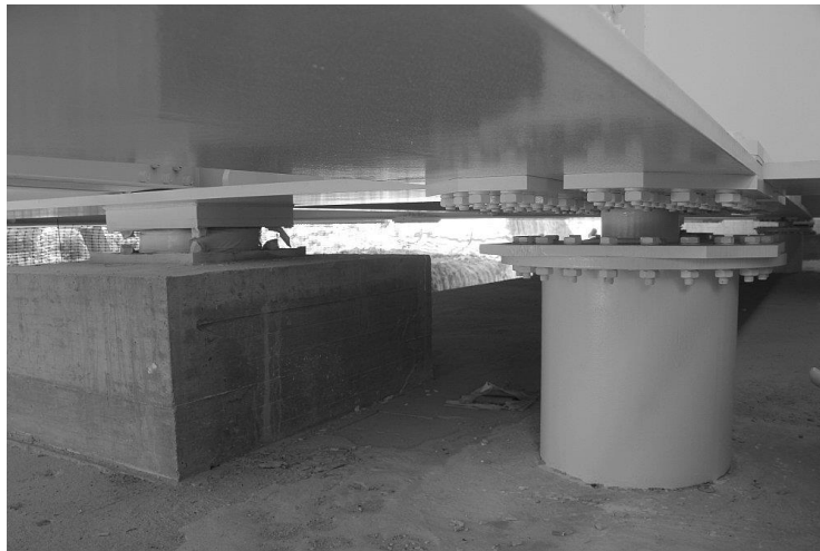
Fig. 6. Il ritegno di finecorsa a taglio (durante la costruzione bloccato temporaneamente e utilizzato come punto fisso)
